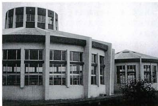
写真1 武漢、水生生物研究所バイジ研究室
